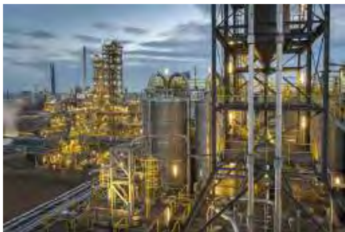
Le consortium Cracker of the future mène un projet pilote qui devrait aboutir à un démonstrateur en 2030. Source : L'Usine Nouvelle 04/21
